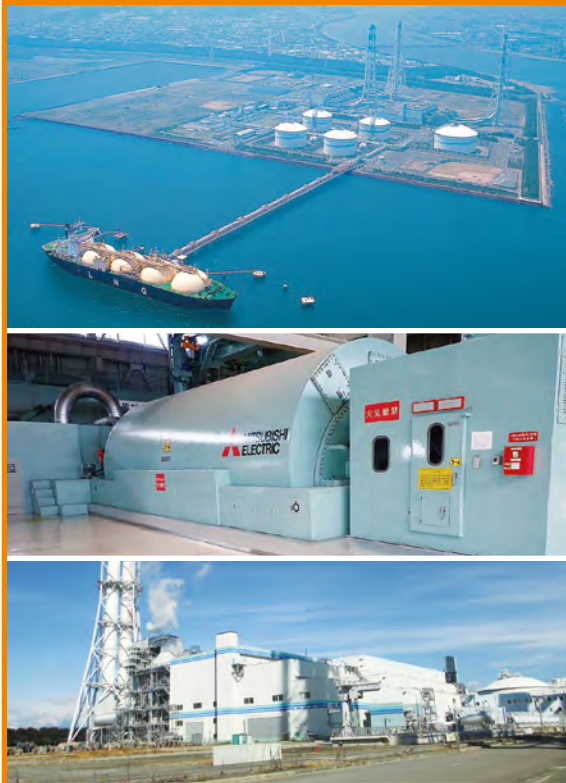
九州電力(株) 新大分発電所
