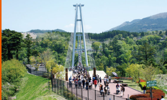
九重“夢”大吊橋 管理センター
